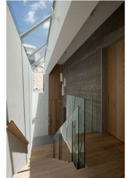
(4) 階段ホール。白い塗装壁、木目仕上げのRC壁、木製の階段にガラスの仕切り、アールの美しい木製手すり、素材や仕上げのバランスがうまく取られた温かみのあるモダンデザイン。
