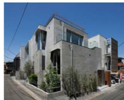
(2) (3) 密集する住宅街の角地に立つ「Tレジデンス」。左は、玄関ファサード。RCの建物は、木目仕上げで品格のある落ち着いた表情。彫刻的な造形美は、機能そのままの現れでもある。
