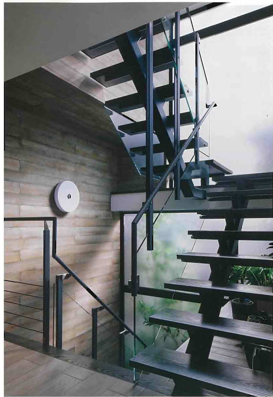
タモ無垢材の踏み板、鋼材とガラスの手すりを用いて軽やかさと硬質さを共存させた階段。隣家が立つ南側を全面スモークガラスとしてプライバシーを確保しつつ光を導いている
